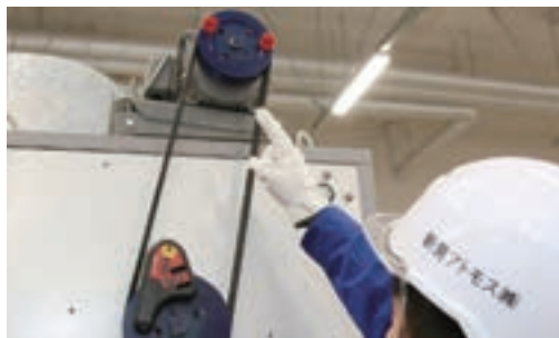
■ プーリーの芯だし調整
